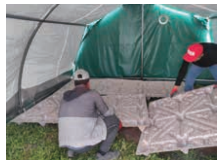
テントの中にパレットを敷く作業 (2023年5月)
